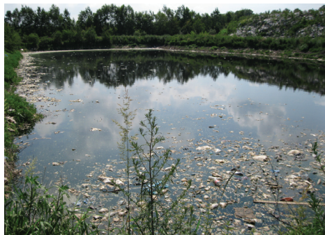
Чек заповнений фільтратом Cell filled with leachate
